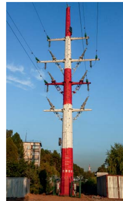
Рис. 1. Переходный пункт ПКПО-КВ-110.1-2.1 расположен в непосредственной близости от жилой застройки
